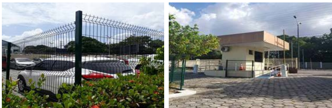
Readequação do estacionamento – Sede do MP/AM
